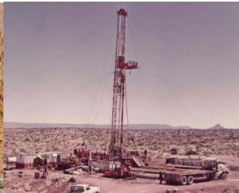
Perforación con recuperación de testigos a más de 1.000 m de profundidad
